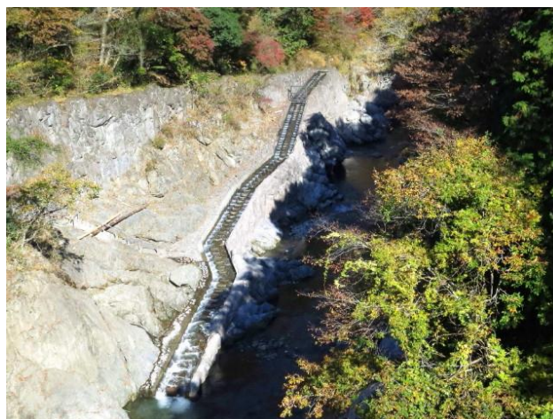
白丸ダムの魚道
