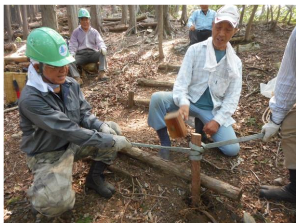
腐食した階段の土留め、杭を交換
