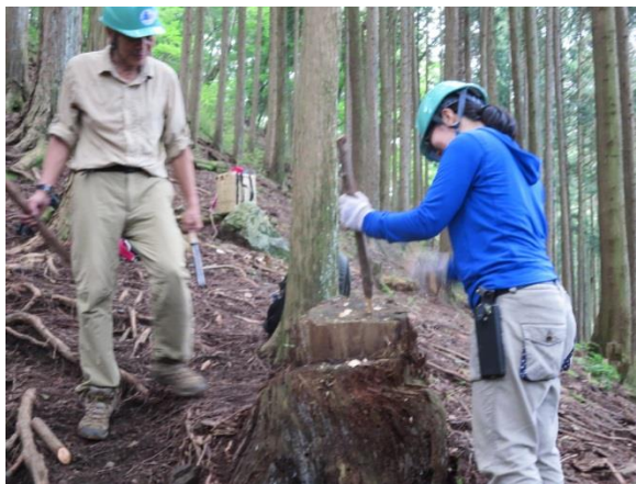
道補修研修中！ 杭作り
